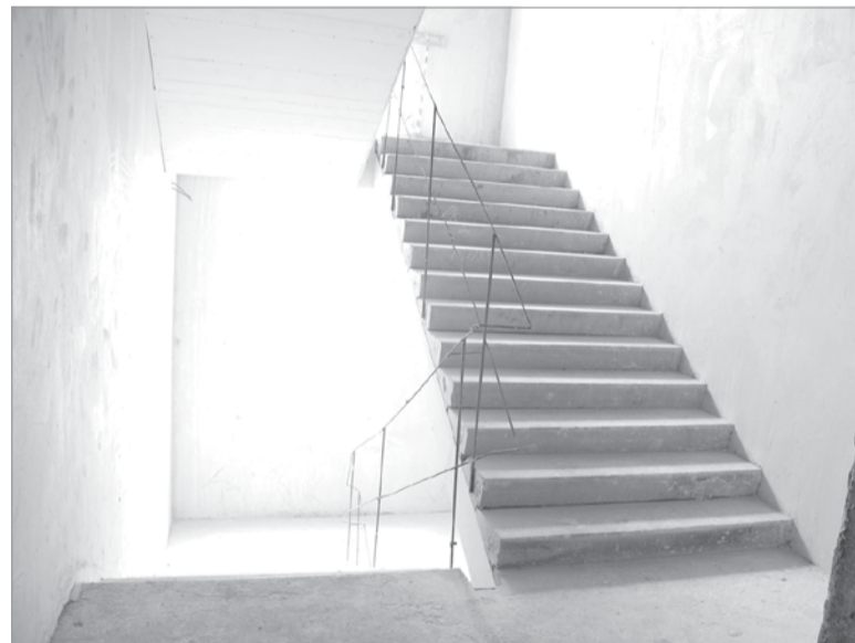
На всех этажах ведутся отделочные работы
